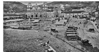
FIGURA 1. Pavimentación de la Plaza de Bolívar. Concejo de Bogotá. Memoria Municipal de Bogotá correspondiente al bienio 1925 a 1927 (Bogotá: Imprenta Municipal, 1927) s.p.
